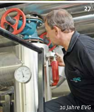
elko: Sicherheit für Energieversorger
