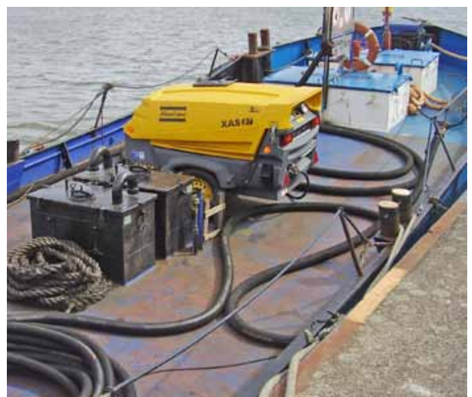
Zusätzlich steht ein separater Kompressor für den Betrieb von 2 Saugpumpen an Deck.
