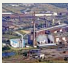
Gemeinschaftskraftwerk Bremen (in Bau)
