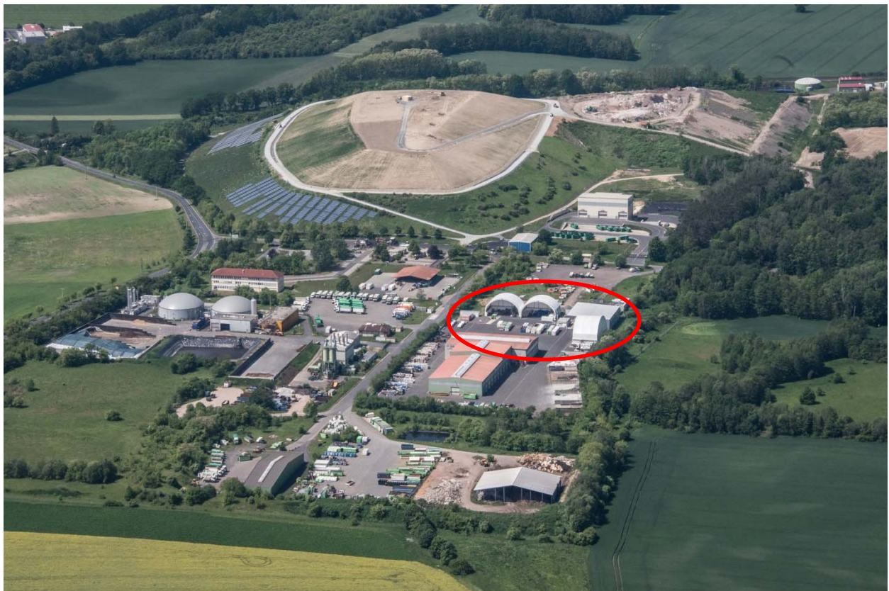
Sonderabfallzwischenlager Gröbern, Luftbild 2019
